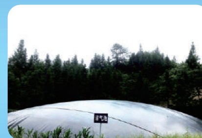
沼气池 Biogas Digester
