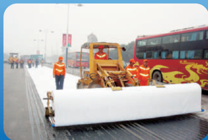
公路路基施工 Highway Subgrade Construction
